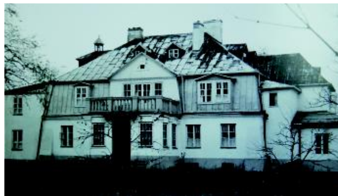
Widok willi „Jutrzenka” w latach 30. XX w. (u góry), oraz po przebudowie dokonanej przez Siostry Niepokalanki
